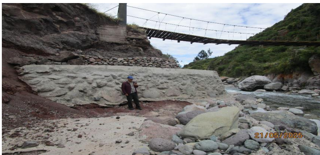
FOTOGRAFIA N°02: TRAMO CRÍTICO EN EL RIO CUSICANCHA, BASE DE PUENTE SOCAVADO.
